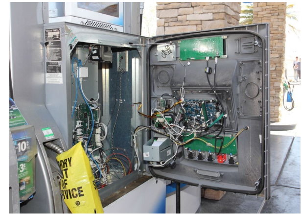
Un skimmer detrás de una bomba de la estación de servicio. Foto cortesía del servicio secreto de los EEUU oficina de campo de Las Vegas.
